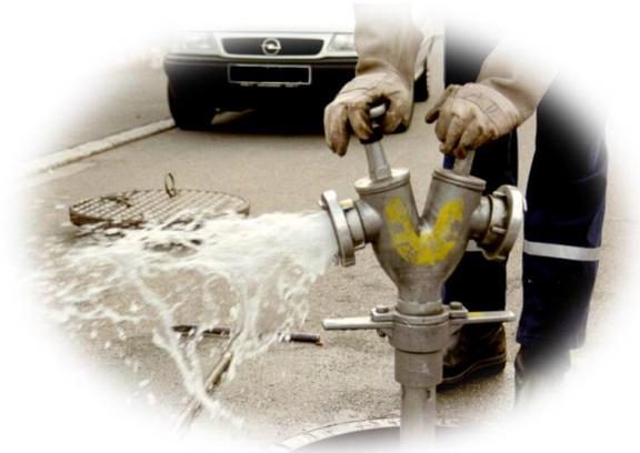
Unterflurhydranten sind unterirdische, stationäre Hydranten. Sie ermöglichen einen schnellen Einsatz mit Wasser auch wenn kein „offenes Gewässer“ oder wasserführendes Fahrzeug in der Nähe ist.
